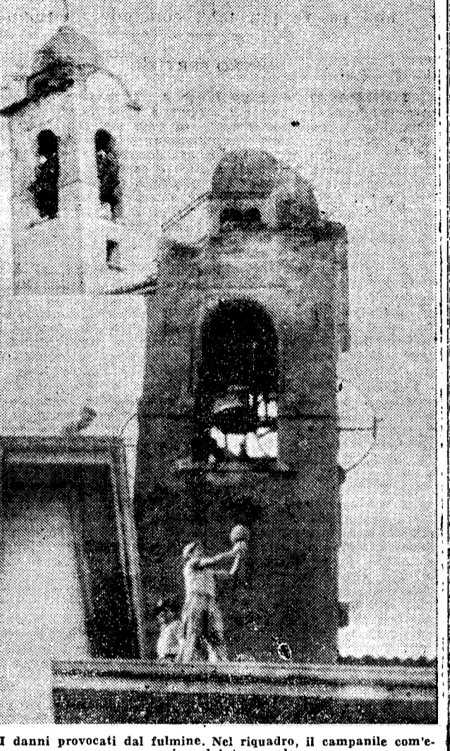
I danni provocati dal fulmine. Nel riquadro, il campanile con la prima del temporale.
