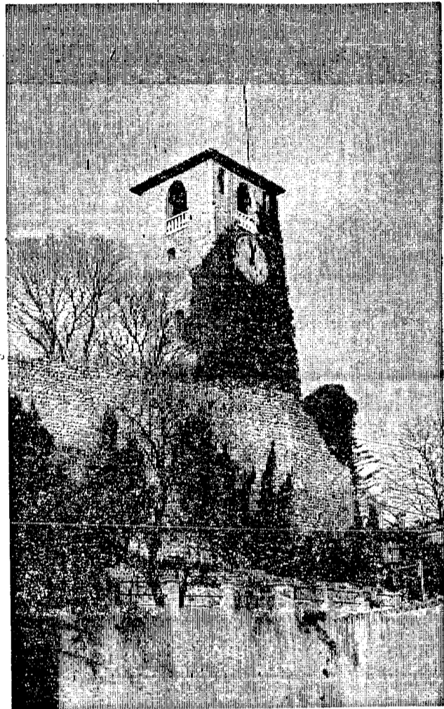
VOLTA MANTOVANA: resti del castello medievale. (Foto CONTE)
